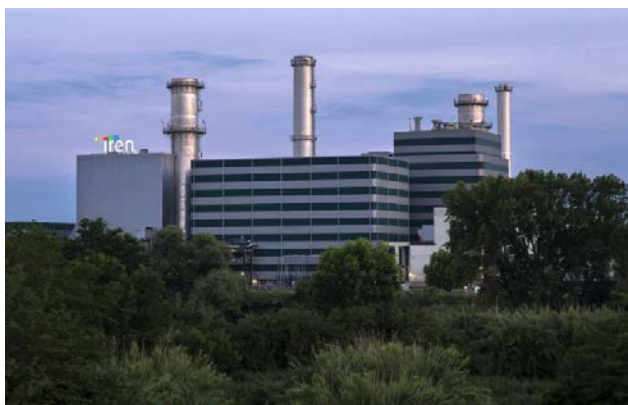
Vista della Centrale dall'abitato di Moncalieri
