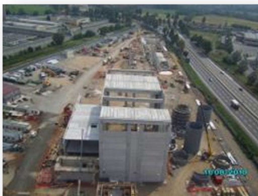
● Area della Centrale in fase di costruzione
