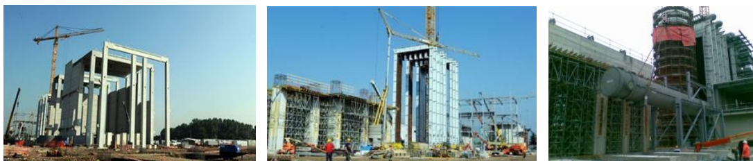
Cantiere di realizzazione della Centrale (2009 ÷ 2011)
