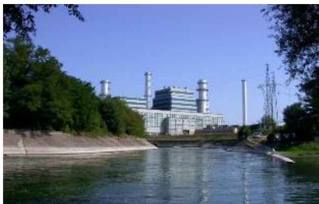
Vista della Centrale dal torrente Chisola
