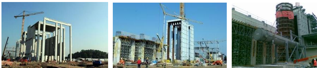
Cantiere di realizzazione della Centrale (2009 ÷ 2011)
