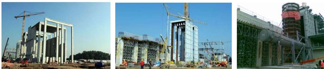
Cantiere di realizzazione della Centrale (2009 ÷ 2011)
