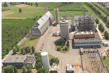
Vista dall’alto del Polo Energetico
