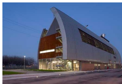
Edificio contenente il gruppo termoelettrico in ciclo combinato
