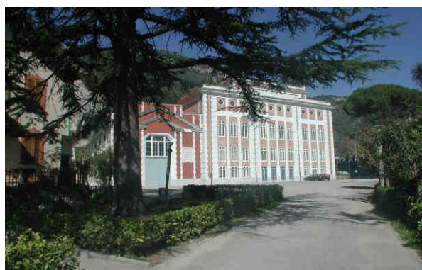
• Fig. 1: Centrale Tusciano (SA).
