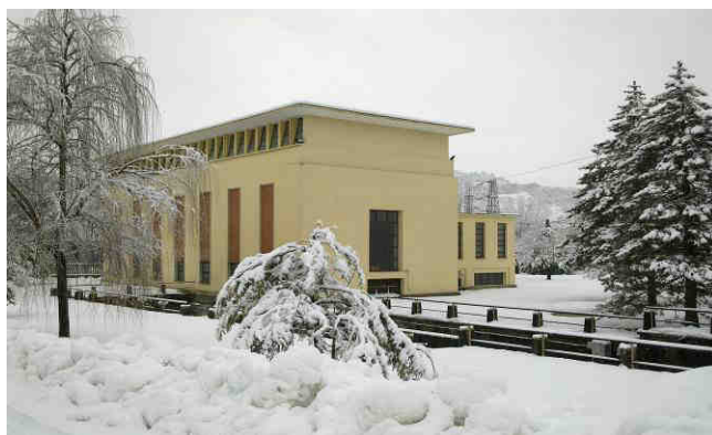
● Fig. 5 Centrale Calore (AV).
