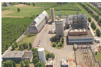
Vista dall’alto del Polo Energetico
