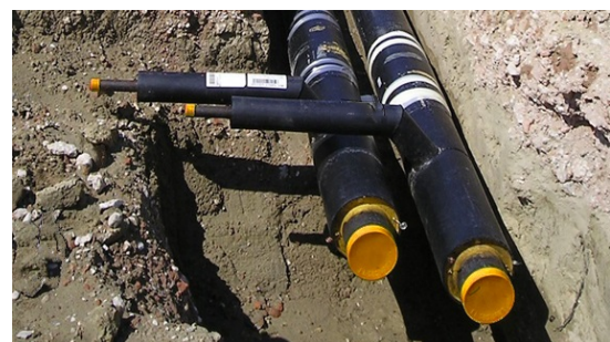
Tubazioni di teleriscaldamento preisolato.
