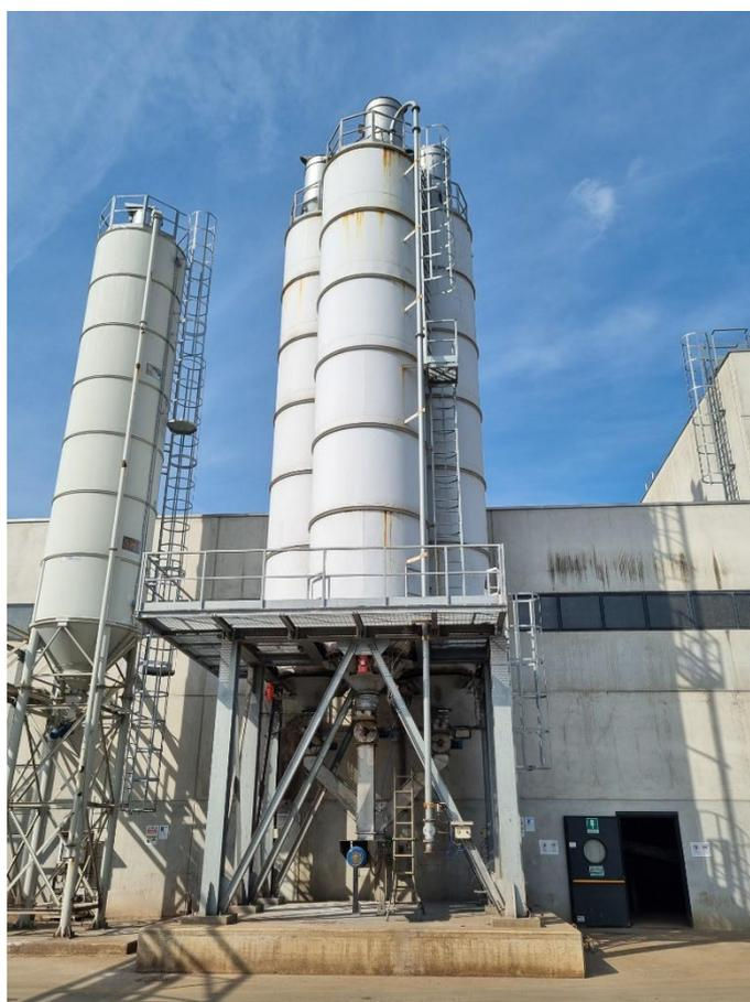
*Figura 7 – Silos stoccaggio rifiuti in polvere*
