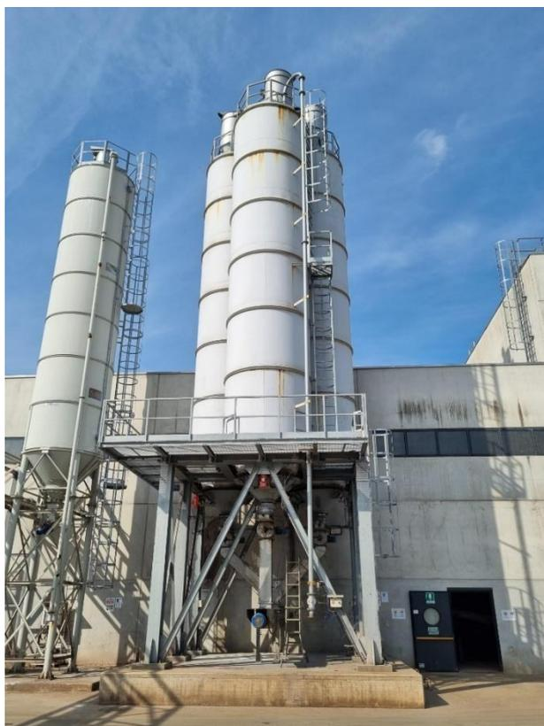
*Figura 8 – Silos stoccaggio rifiuti in polvere*
