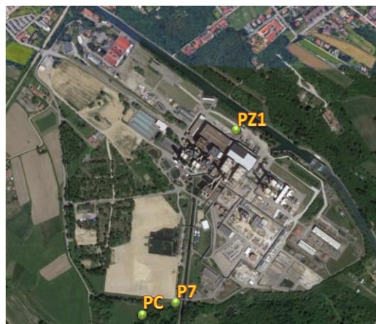
Centrale di Turbigo: pozzi piezometrici AIA di monitoraggio della falda
