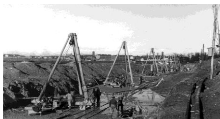
La diga del Pascolo in costruzione - anni '50
