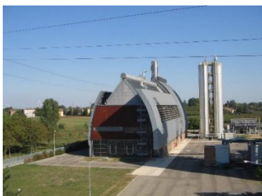
Vista frontale e dall'alto del Polo Energetico
