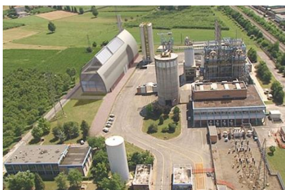
Vista dall’alto del Polo Energetico
