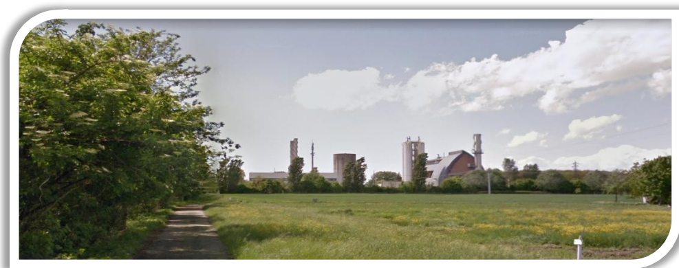
Vista della Centrale da Via Cesare Campioli, Reggio Emilia
