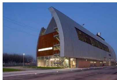
Edificio contenente il gruppo termoelettrico in ciclo combinato
