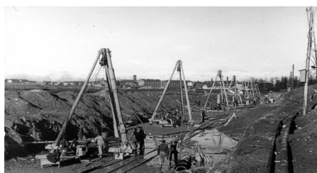
La diga del Pascolo in costruzione - anni '50
