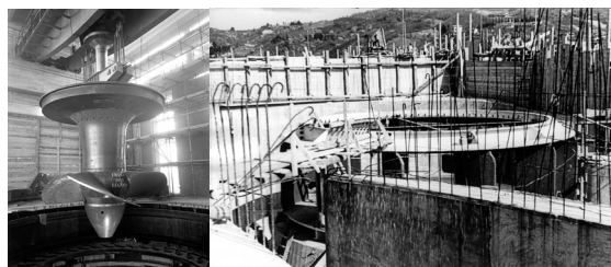
La Centrale di San Mauro in costruzione - anni '50
