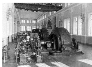
Sala macchine Centrale Rosone - 1930
