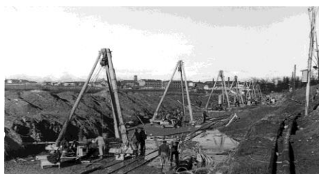
La diga del Pascolo in costruzione - anni '50
